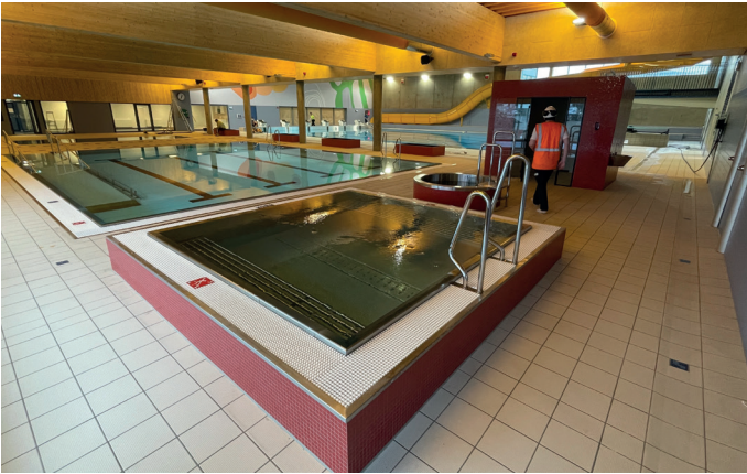
Opplæringsbassenget i midten av bildet har hev- og senkebunn slik at man kan drive sikker opplæring på ethvert nivå. Nærmest ses terapi-bassenget med kroppstemperatur, og til høyre dampbadstu.
