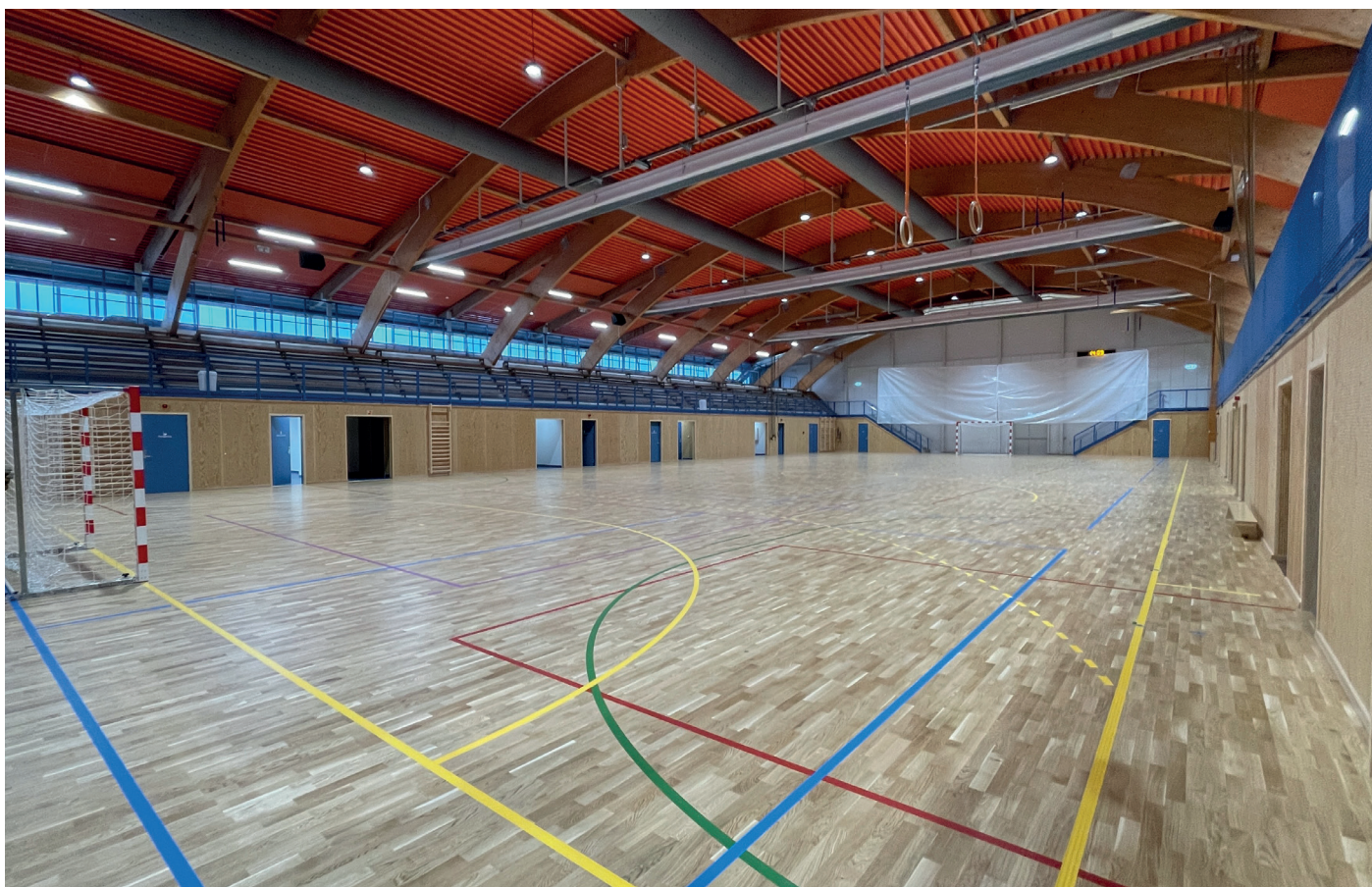
Den gamle håndballhallen har fått etterisolering, nye tekniske anlegg, oppussede garderober og nytt banedekke.
